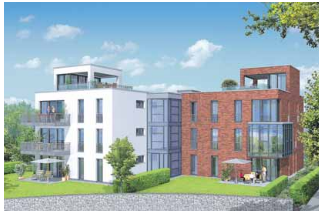
Die energetischen Gebäude werden mittels thermischer Solaranlage energieeffizient unterstützt.
